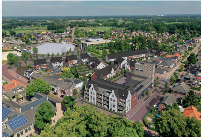
Helicopterview van het project RemmensBerg; heel snel wordt hier een begin gemaakt met de bouwwerkzaamheden van fase 1.
